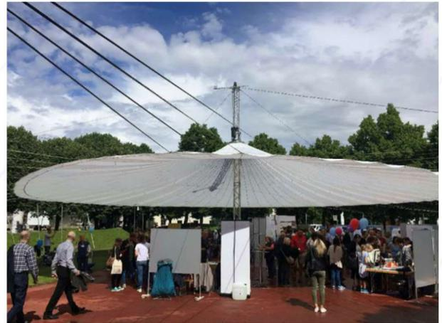
Mit einem zentralen Mast steht der Schirm innerhalb kurzer Zeit. Die Variante ist leicht zu transportieren, ästhetisch ansprechend und statisch belastbar.
